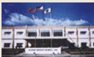
Hitachi Air Conditioning, Филиппины
